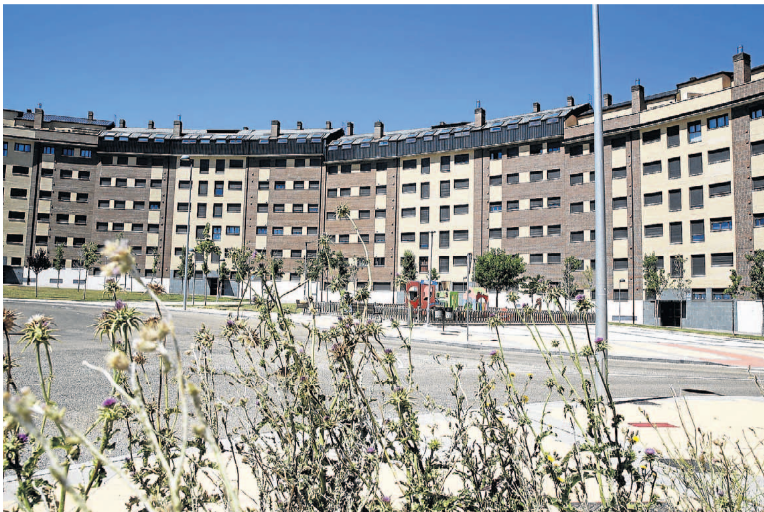
Viviendas sin terminar de la Cooperativa Parque Príncipe, en Arroyo de la Encomienda (Valladolid). :: G. VILLAMIL
