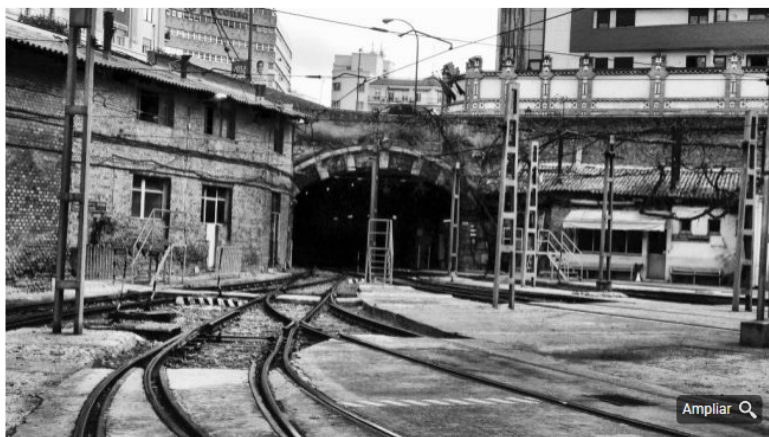
Cocheras de Cuatro Caminos
