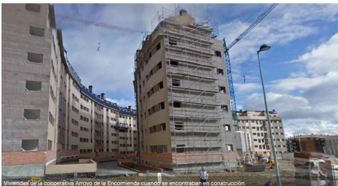
Viviendas de la cooperativa Arroyo de la Encomienda cuando se encontraban en construcción.
